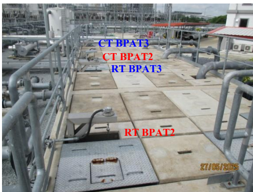
รูปที่ 3-24 บ่อตรวจสอบสภาพน้ำ (Inspection Manhole)
