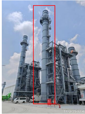
รูปที่ 3-5 ปล่อง HRSG 31
