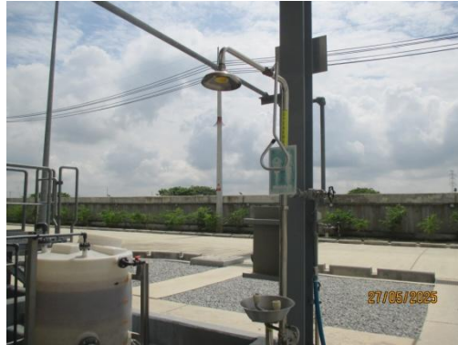
รูปที่ 3-45 อุปกรณ์ชำระล้างฉุกเฉิน (Emergency Shower and Eye Wash)
