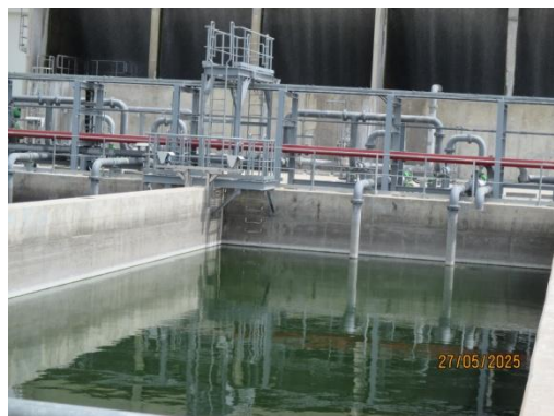
รูปที่ 3-20 บ่อพักน้ำทิ้งจากหอหล่อเย็นฉุกเฉิน (Emergency CT Blow Down Pit)
