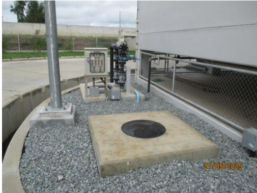
รูปที่ 3-22 ระบบบำบัดน้ำเสียสำเร็จรูป (Septic Tank)
