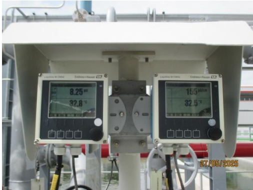
รูปที่ 3-27 ระบบตรวจสอบคุณภาพน้ำแบบต่อเนื่อง (Online Monitoring) ที่บ่อกักน้ำทิ้ง (Retention Pit)
