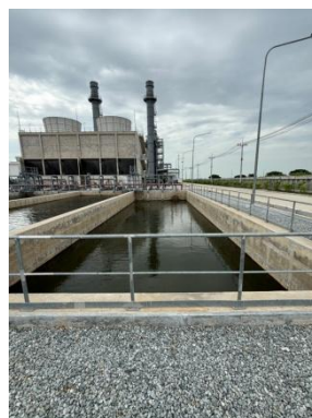
รูปที่ 3-26 บ่อพักน้ำทิ้งฉุกเฉิน (Emergency Pit for Retention Pit)
