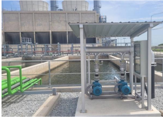
รูปที่ 3-16 ปัมป์สูบน้ำกลับมาใช้รดน้ำต้นไม้
