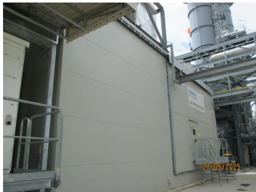
รูปที่ 3-12 ที่ครอบลดเสียง (Enclosure)
